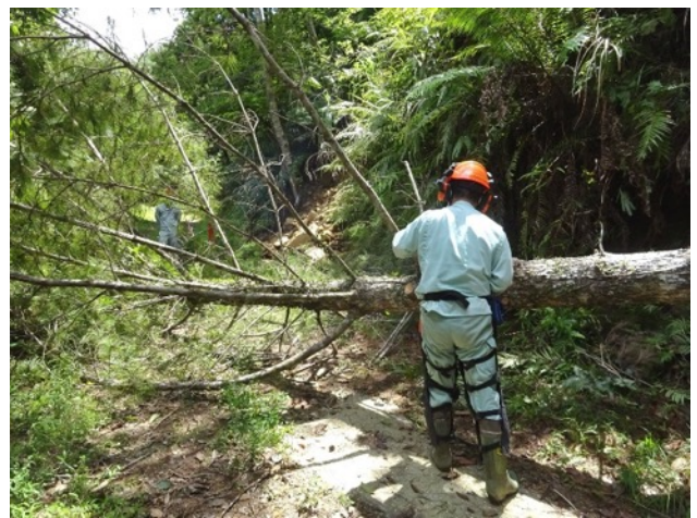
写真 I-29 林道法面のリュウキュウマツ危険木の除去 (左) 伐倒前の状況、(右) 伐倒後の枝払い
