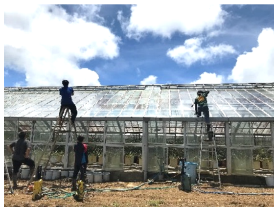
写真 I-17 ガラス室屋根の洗浄の様子
