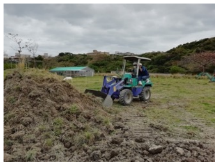
写真 I-12 ホイルローダの操作
