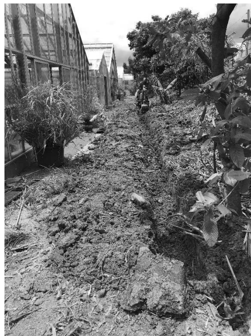
写真 I-25 ハウス裏の排水改善の様子
