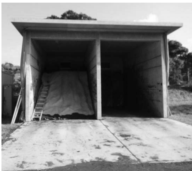
写真 1 超高温好気性発酵堆肥化施設 (2.8 m の堆積物斜面にブルーシートを被せ水分の蒸発を防止)
