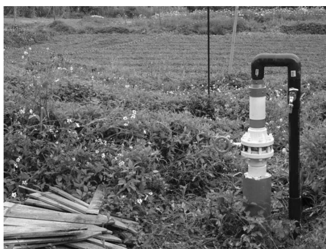
写真 I-11 1 番圃場中水工事後の様子
