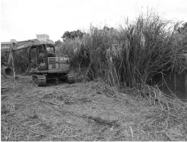
写真 I-8 15 番ハウス周辺整備の様子
