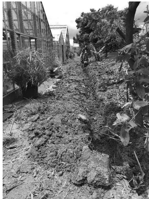
写真 I-25 ハウス裏の排水改善の様子
